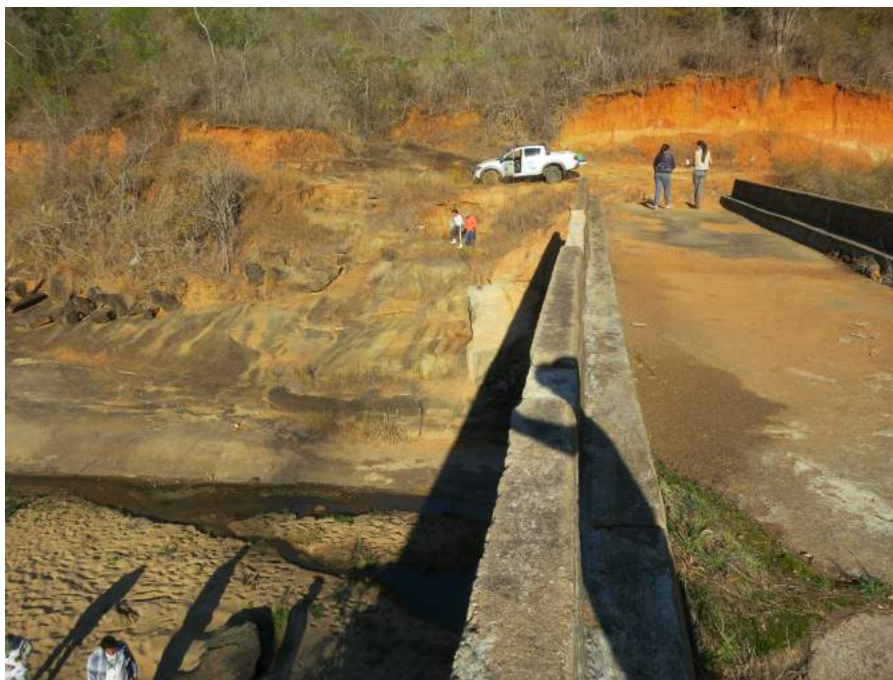
FIGURA 29: VISTA DA MARGEM DO RIO GRANDE A PARTIR DA RUÍNA DA PONTE
