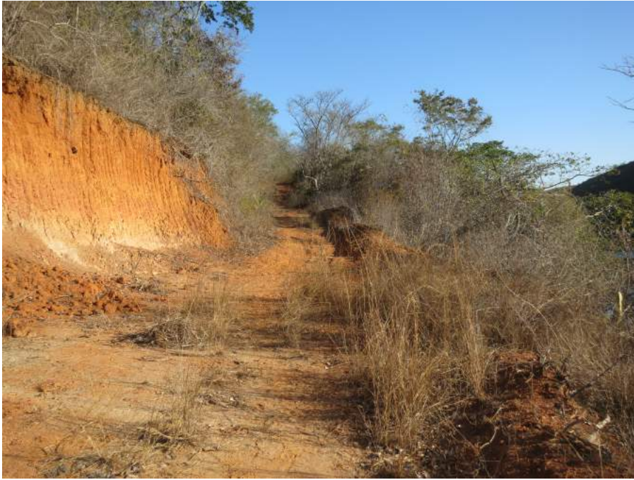
FIGURA 24: IMPACTO DO MANEJO INCORRETO DO SOLO AO LONGO DA ESTRADA NO TRECHO EM SÃO FIDÉLIS
